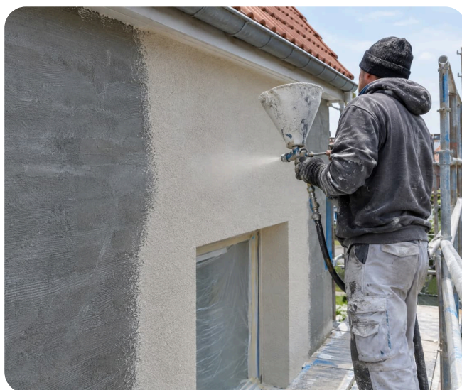
Aanbrengen van de sierpleister, vlak per vlak.
