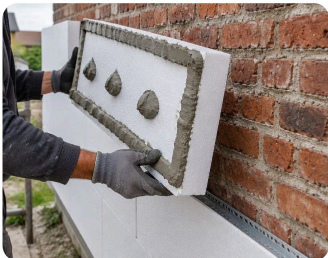
Verlijmen met de rand-puntmethode: een volle rand en enkele dotten.
