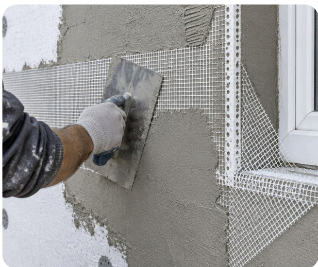
Glasvezelweefsel met overlap en diagonale wapening aan de raamhoek.
